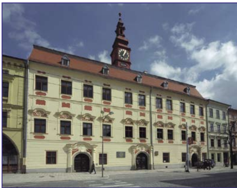
Zrekonstruovaná fasáda jihlavské radnice na Masarykově náměstí.
