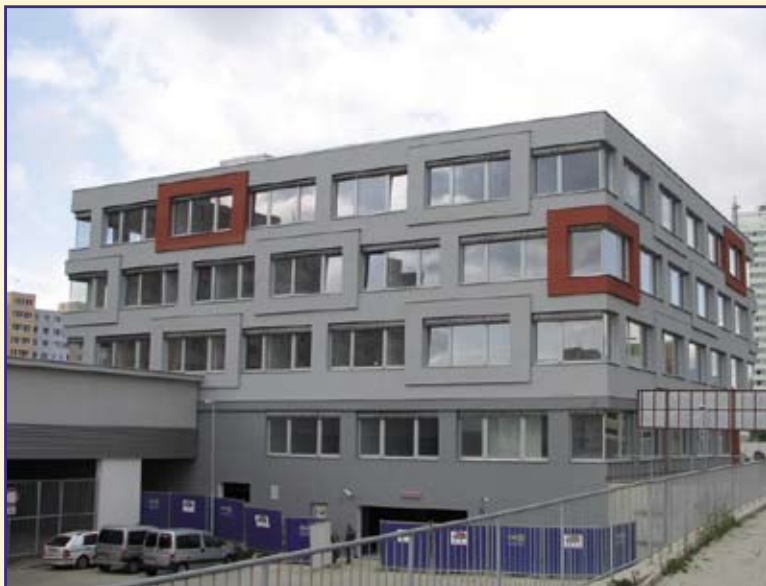
V této budově bude sídlit Finančního úřadu pro Prahu – Jižní město.
