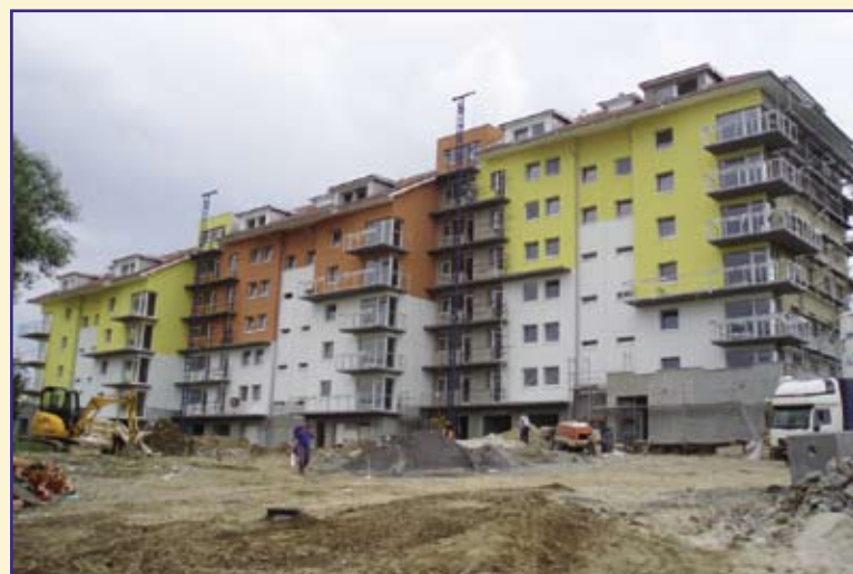
Bytový dům v Dolnokubínské ulici v Pelhřimově už zdobí nová fasáda.
