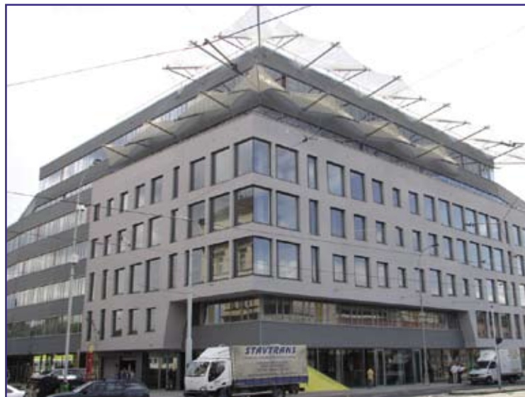
Dokončená budova F projektu Factory Office Center na Smíchově. Foto: PSJ
