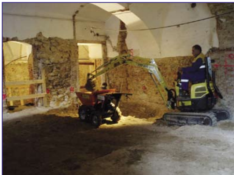
I do vnitřních odkrývacích prací je v Herálci zapojena mechanizace.
