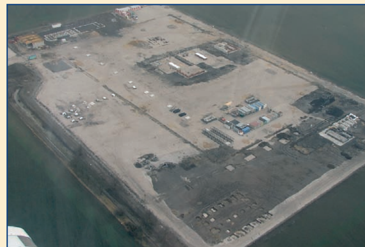
Letecký snímek ze slovenské obce Gajary, kde PSJ Hydrotranzit staví významnou část II. etapy centrálního skladového areálu pro uložení zemního plynu.
