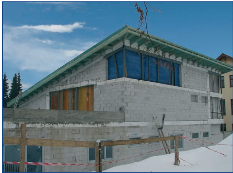
Stavba rehabilitačního pavilonu Dětského centra v Jihlavě bude dokončena v červnu 2010.
