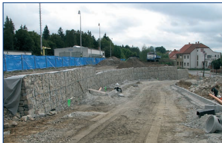
Budoucí nájezd na telčské autobusové nádraží podél nové opěrné zdi.
