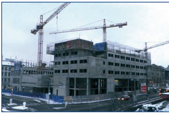
Lednový snímek staveniště polyfunkčního komplexu CPI City Center v Ústí nad Labem. Foto: PSJ
